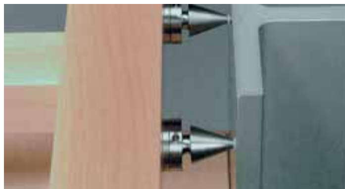
Schwingungsableiter 2: Horizontalverspannung im T-Träger
